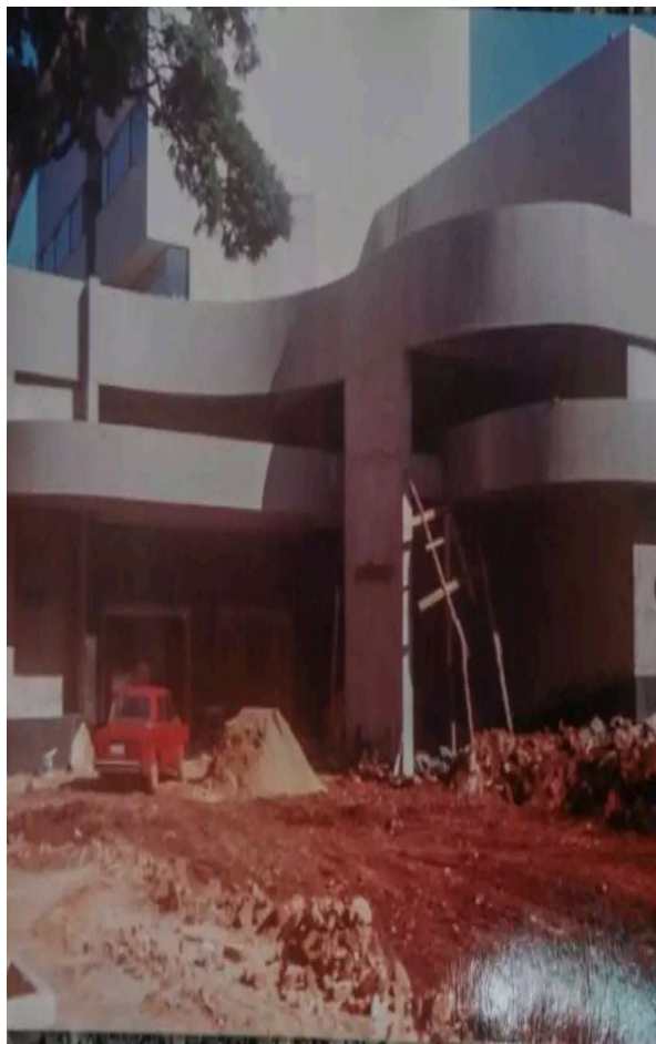
Recepção sendo construída em 1994.
