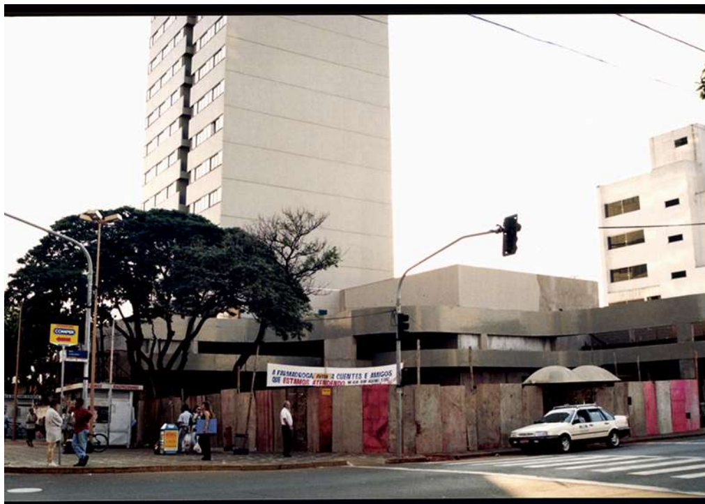
Obras no Hotel Jandaia - (Foto: Arquivo/A Crítica)
